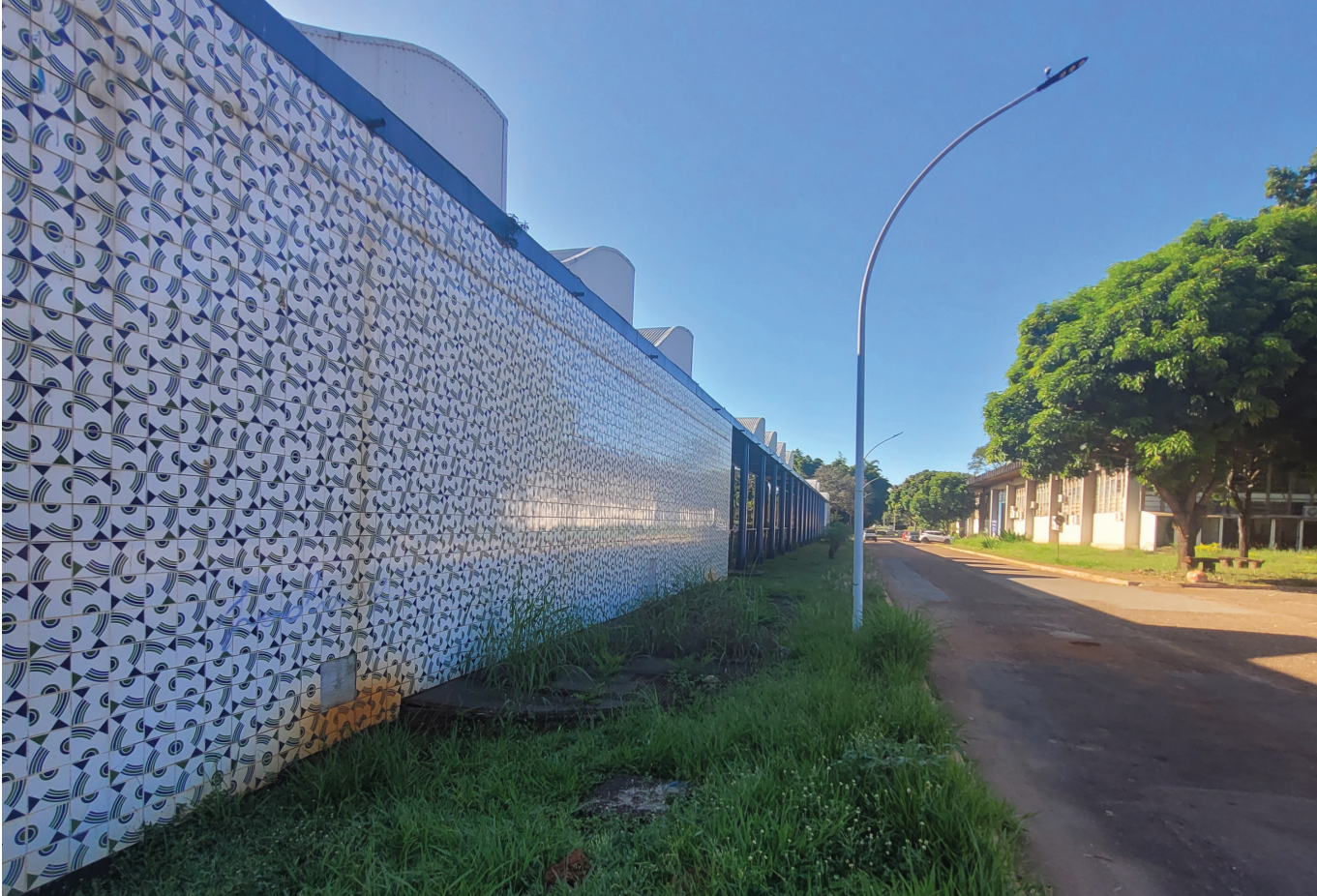
V6 Vista 06 - Fachada Oeste
