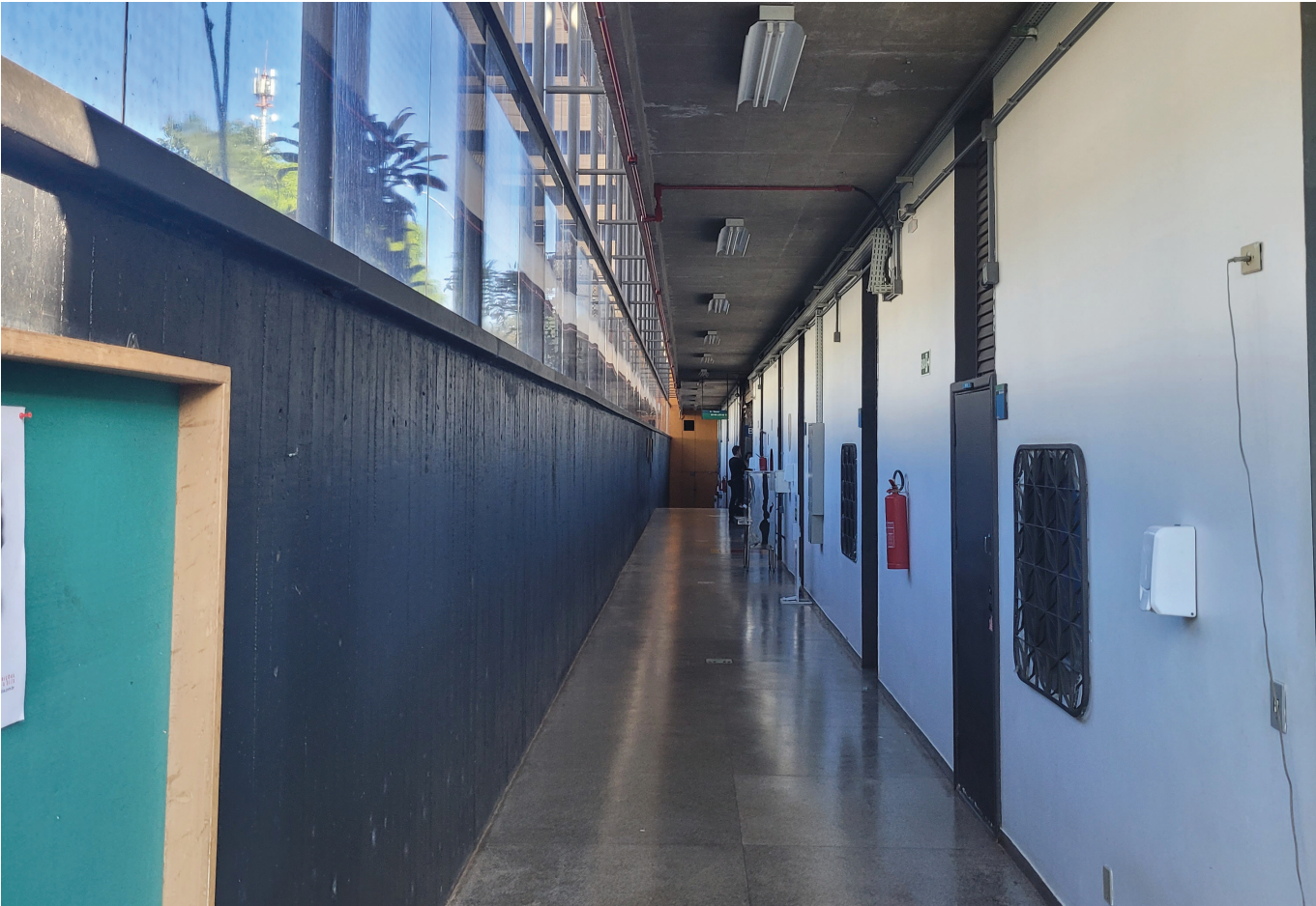
V3 Vista 03 - Corredor interno
