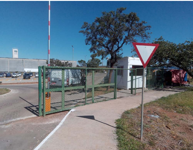
Vista - Guarita Leste
